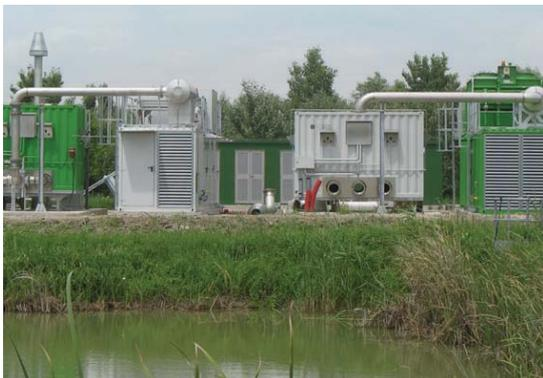
La ICQ Holding SpA ha di recente ultimato l'impianto di produzione di energia elettrica alimentato a biogas da Rifiuti Solidi Urbani presso la discarica Gal.A Srl (Gruppo HERA) nel Comune di Galliera (BO). L'impianto è composto da un motore della potenza di 1,4 MW e la producibilità prevista è di oltre 10.000.000 kWh/anno.
